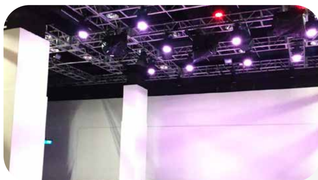
牛池灣文娛中心文娛廳安裝了舞台專用電腦燈光系統，以提升場地的技術水平。
